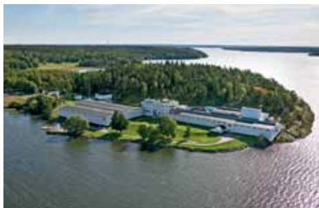
Norrvattens reningsverk vid Görvälnverket.
